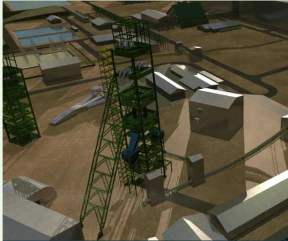
Elevadores de Acesso (Shafts)
